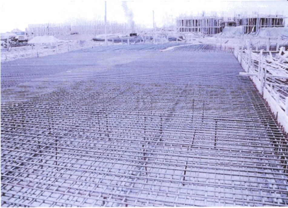
لبشة لأساسات مبنى أرضى
